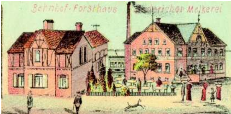
Bahnhof Forsthaus mit der alten Molkerei
